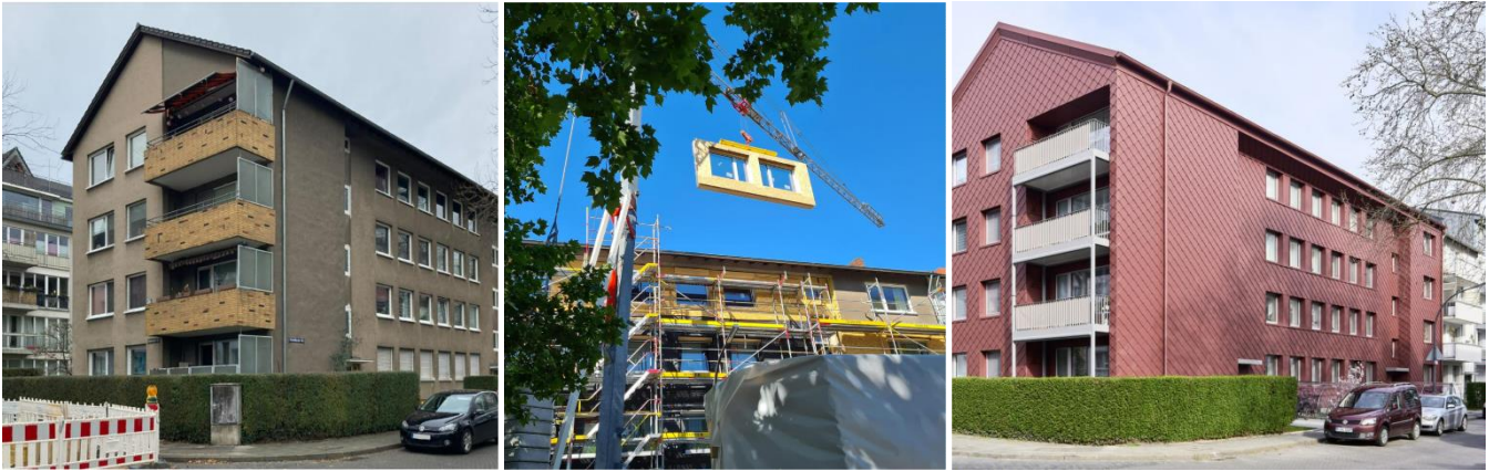
Sanierung in Köln vorher (l.) und nachher (r.): Dieses Wohnhaus Baujahr 1961 ist nach der Sanierung mit vorgefertigten Elementen in Passivhaus-Qualität sogar ein Passivhaus Plus, auf dem Dach gibt es eine großflächige PV-Anlage. Für diese Sanierung wurde ein Gerüst aufgestellt. © Fotos 1 & 2: Zeller Kölmel Architekten // Foto 3: dena | Jens Willebrand
