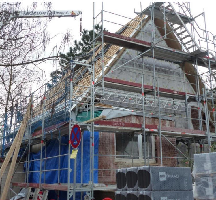
Beim Passivhaus-Abend im März steht die Sanierung dieses Einfamilienhauses in Darmstadt im Fokus. Vom Keller bis zum Dach werden Passivhaus-Komponenten verwendet. © Passivhaus Institut
