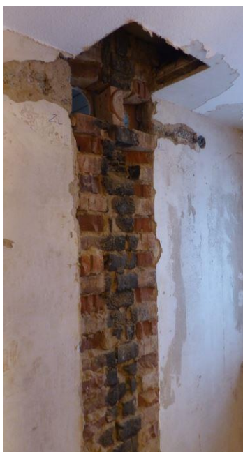
Am früheren Kaminschacht verlaufen zukünftig die Leitungen der Lüftungsanlage. © PHI
