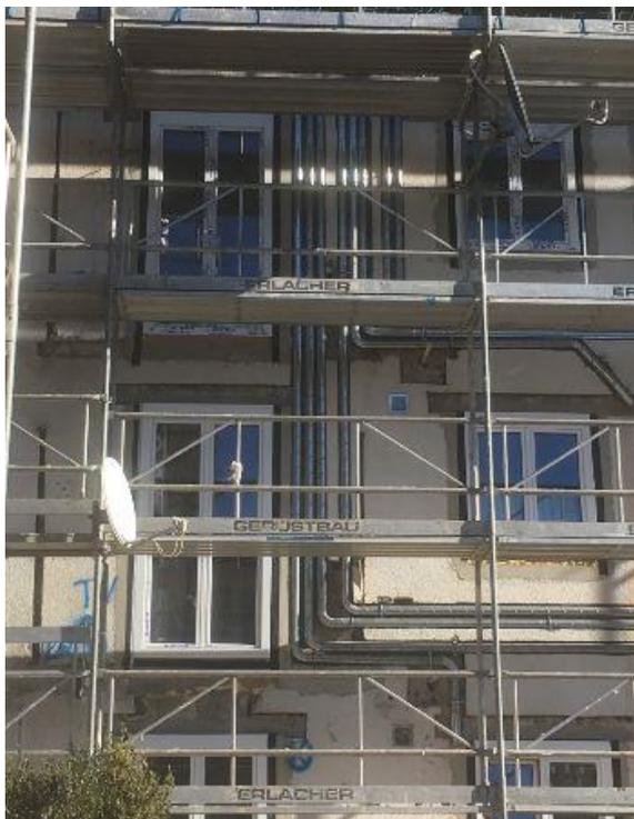
Zahlreiche Lüftungsrohre wurden in die Fassade integriert, anschließend erhielt diese eine Dämmung. Ein guter Wärmeschutz ist die Trumpfkarte, um den Energiebedarf von Gebäuden deutlich zu reduzieren.
