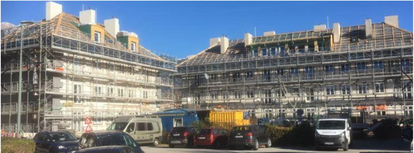
Der Verbrauch für Heizwärme bei diesen Innsbrucker Wohngebäuden ist nach der Sanierung um bis zu 77 Prozent zurückgegangen. Diese deutliche Reduzierung war keine Überraschung, sondern wurde zuvor mit dem Energiebilanzierungstool PHPP berechnet. Einzelheiten dazu gibt es beim Passivhaus-Abend am 27. September 2023. © Passivhaus Institut
