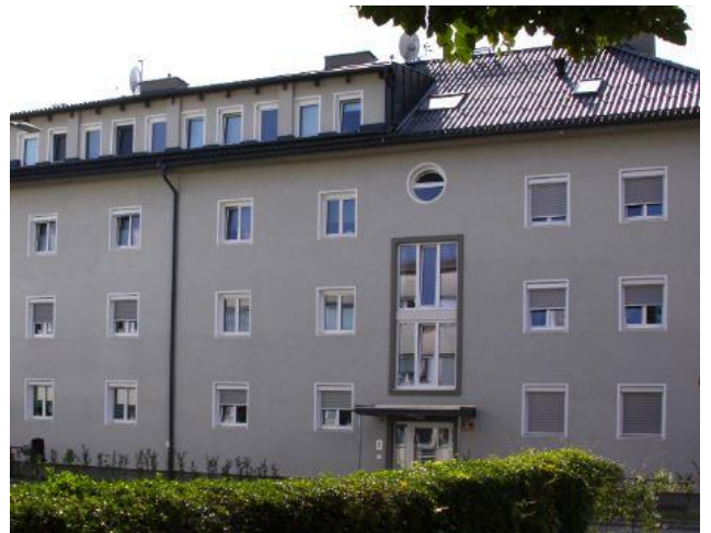
Innsbruck: Besichtigt werden kann auch dieses von der Neuen Heimat Tirol zum EnerPHit-Standard sanierte Mehrfamilienhaus. ID 5673 © PHI
