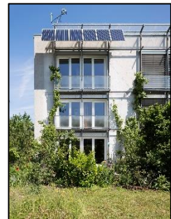
Das weltweit erste Passivhaus in Darmstadt-Kranichstein. © Peter Cook
