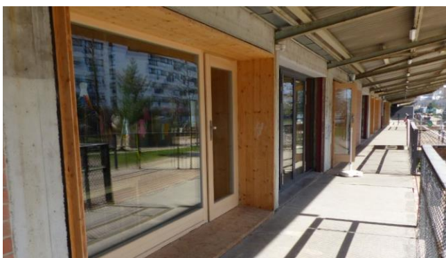
In der Bahnstadt beherbergt ein Gebäude des früheren Güterbahnhofs nach der Sanierung Eventhalle und Kita.
