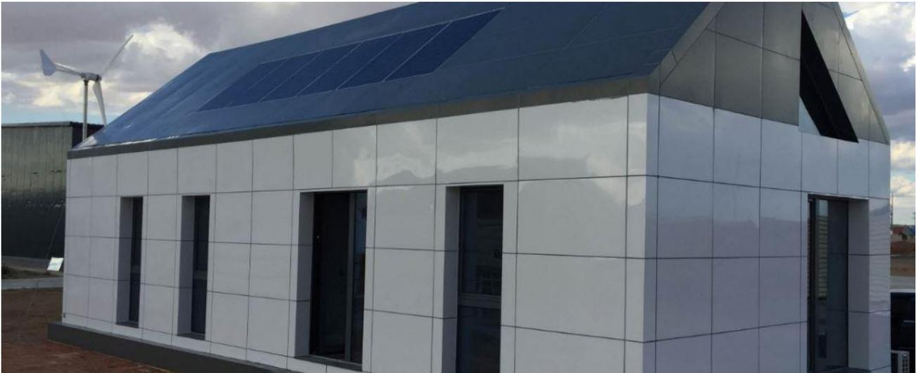
Die Schiffscontainer nach der Bearbeitung: Die Fassade des Passivhaus-Pilotprojektes besteht aus eloxierten Aluminiumtafeln, in denen sich die Landschaft spiegelt. Die Bodenplatte kann im Winter die Wärme lange speichern und hilft im Sommer, das Gebäude angenehm zu kühlen. In der Mongolei soll vor allem die Landbevölkerung komfortablen Wohnraum erhalten, um die Flucht in die Städte zu mindern. © Ludwig Rongen
