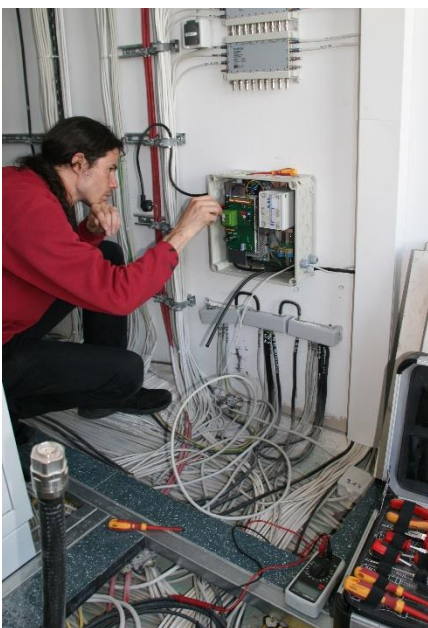
Schon im Rohbau verlegten die Mitarbeiter des Passivhaus Instituts zahlreiche Kabel und Sensoren für das spätere Monitoring. Rechts: Lüftungsrohre im Flur des Verwaltungsgebäudes in Baunatal.
