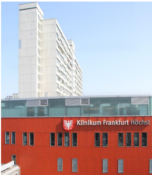
Das Passivhaus Institut hat untersucht, wie die hoch energieeffiziente Passivbauweise in einer Klinik umgesetzt werden kann. Diese Erkenntnisse könnten auch den weiteren 2.100 Kliniken in Deutschland zu Gute kommen.
