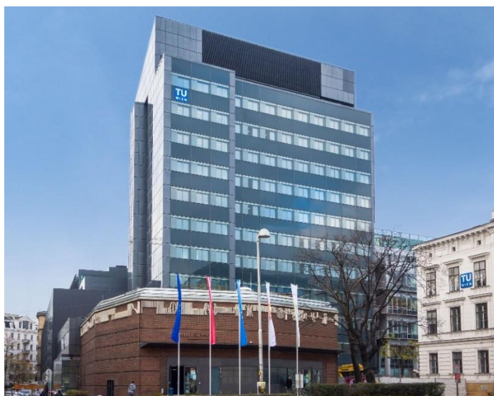
Die TU Wien hat ihr Gebäude am Getreidemarkt zum Passivhaus saniert und den Energiebedarf von 804 auf 56 kWh/(m 2 a) reduziert. Zudem erzeugt sie 61 kWh/(m 2 a) erneuerbare Energie. Foto: Schöberl & Pöll
