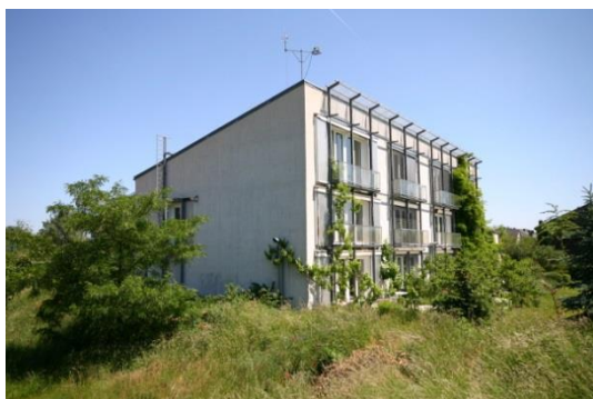
Seit 25 Jahren hoch energieeffizient: das weltweit erste Passivhaus in Darmstadt. Foto: Passivhaus Institut
