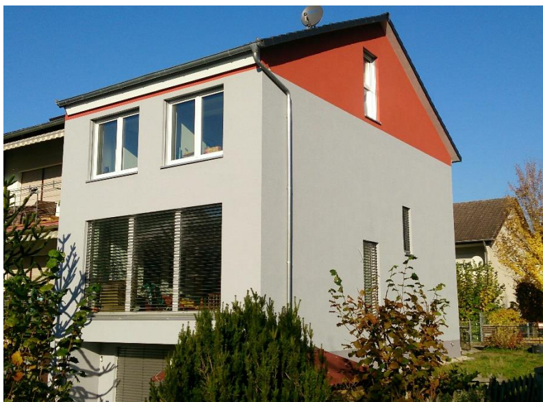
Nach der Sanierung: Familie Baumgärtner aus Laudenbach zeigt an den Tagen des Passivhauses, dass auch Altbauten den energieeffizienten Passivhaus-Standard erreichen können. Foto: C. Baumgärtner
