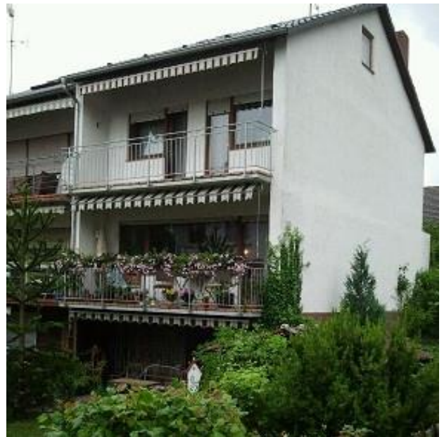
Vor der Sanierung: Ein typisches Reihenhaus aus den siebziger Jahren. Foto: C. Baumgärtner
