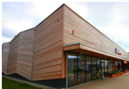
Optisch überzeugt der Verbrauchermarkt mit einer natürlichen Holzfassade. Foto: PHI
