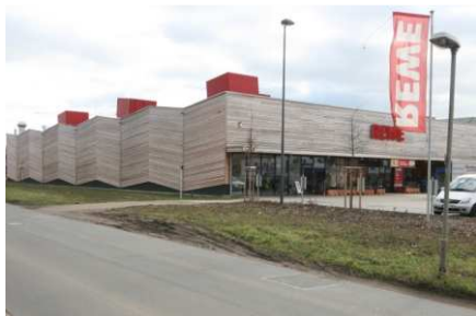
Der im Passivhaus-Standard gebaute Supermarkt in Hannover. Foto: PHI
