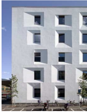
EXPOST-Gebäude in Bozen, Architekt: Michael Tribus, Foto: Rene Riller
