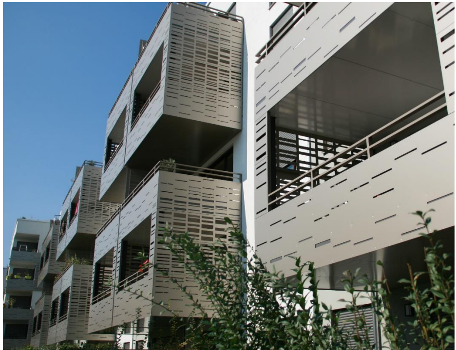
Eine gute Verschattung wie bei diesen Wohnungen im Heidelberger Passivhaus-Stadtteil Bahnstadt sowie eine Nachtlüftung sind häufig ausreichend für angenehmen Sommerkomfort. Foto: Passivhaus Institut
