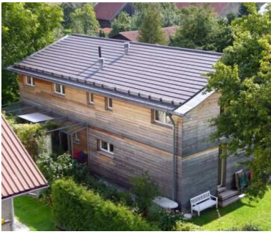
Ein Passivhaus-Einfamilienhaus im bayerischen Biburg-Alling. Foto: Justus Well
