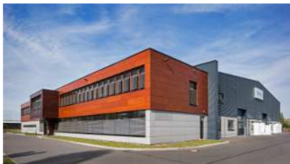
Ein Passivhaus und zugleich Sitz eines Herstellers von Passivhaus-Komponenten in Reinsdorf/Sachsen.
