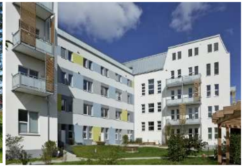
Ein nach dem EnerPHit-Standard für Sanierungen zertifiziertes Gebäude in Hamburg. Foto: Markus Tollhopf
