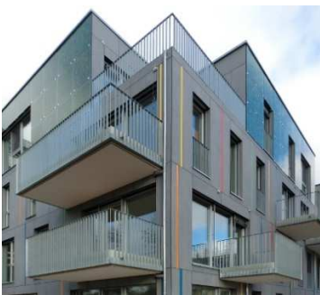
Neubau im Passivhaus-Standard in Tübingen-Lustnau.
