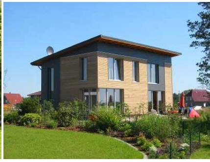
Wohnhaus im Passivhaus-Standard in Westerstede/Niedersachsen. Foto: Christian Gauler
