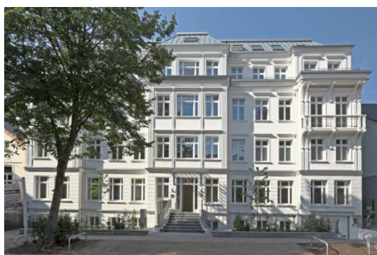
Ein Passivhaus-Neubau im Gründerzeitstil: das „Haus Winter“ in Hamburg. Foto: Jörn Hustedt
