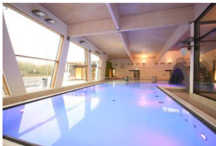
Passivhaus-Fenster sorgen auch im Hallenbad für hohe Energieeffizienz. Foto: PHI
